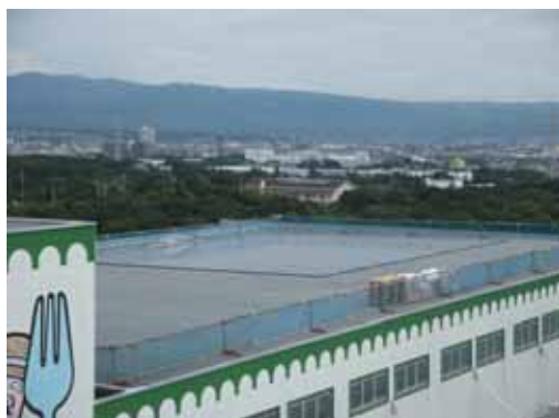
物流センター屋上パネル
